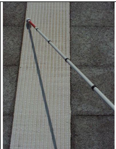
Abb. 13 c: Rippenstruktur/Kaltplastik (Böblingen) 20/3,5 mm Leitfunktion: 3,30 Aufmerksamkeitsf.: 3,87 FüÙe: 5,78
