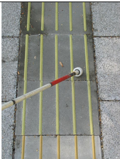
Abb. 13 b: Farbrippen (Niederlande) 60/3 mm; Leitfunktion: 3,17; FüÙe: 3,22
