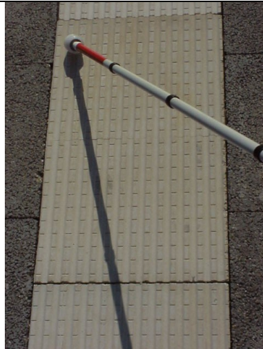
Abb. 13 e: Flachrillen-Struktur (Leipzig) 20/3 mm Leitfunktion: 3,61 FüBe: 6,00
