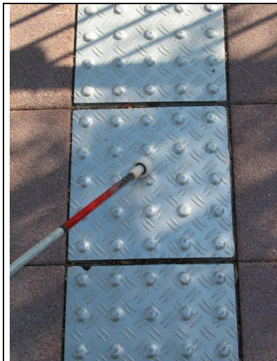
Abb. 11a: Klangtegels (Noppenblech, Holland); 57/4,5 mm Aufmerksamkeitsf.: 1,10
