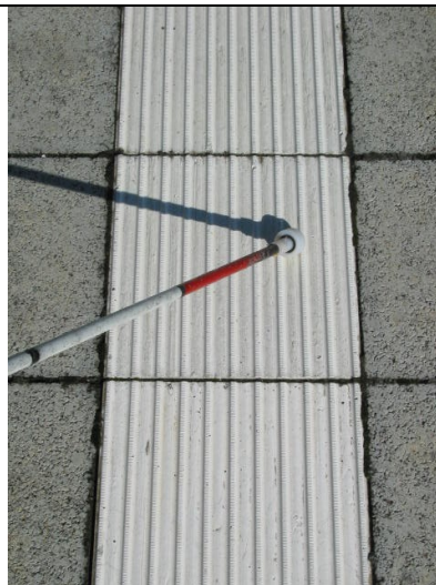
Abb. 12 b: Rippenstruktur 30/2,5 mm Leitfunktion: 2,48 Aufmerksamkeitsf.: 3,15 Füße: 5,70
