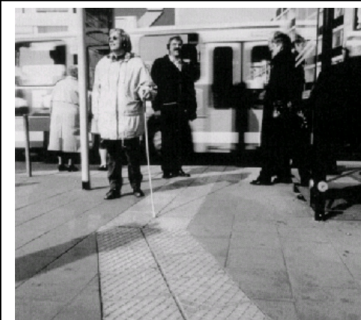
Abb. 3: Die „Orientierungsplatte“ aus Münster/Westfalen belegte mit deutlichem Abstand zu den übrigen Strukturen den letzten Rangplatz - von vielen Testpersonen wurde sie überhaupt nicht wahrgenommen. Sie ist als ungeeignet abzulehnen. (Abbildung entnommen aus „direkt“ Nr. 54, s. Anm. 4)
