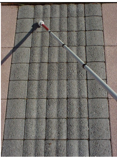
Abb. 12 e: Blinden-Führ- Steine (Stuttgart) 50/5 mm Leitfunktion: 2,72 Aufmerksamkeitsf.: 3,54 Füße: 2,78
