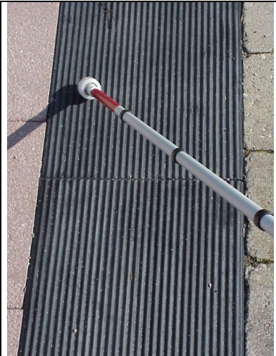
Abb. 13 f: Hartgummi-Rillenplatte (Hamburg) 0/3 mm Leitfunktion: 3,63 Aufmerksamkeitsf.: 3,32 (gute Ergebnisse mit Keramikspitzen, mangelhafte mit Rollspitzen) FüBe: 6,00
