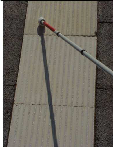
Abb. 13 d: Rillenstruktur (Berlin) 20/4 mm Leitfunktion: 3,34 Aufmerksamkeitsf.: 4,33 FüBe: 6,00
