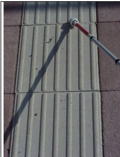
Abb. 12 a: Geleidelijn ("halbe Zigarren"; Niederlande) 45/5 mm Leitfunktion: 2,41 Aufmerksamkeitsf.: 2,65 Füße: 3,36
