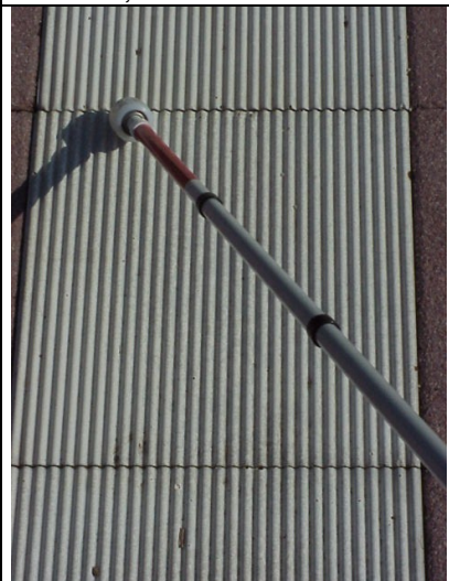
Abb. 13 h: Rillenstruktur (Hamburg) 10/3 mm Leitfunktion: 3,90 Aufmerksamkeitsf.: 4,95 FüBe: 6,00
