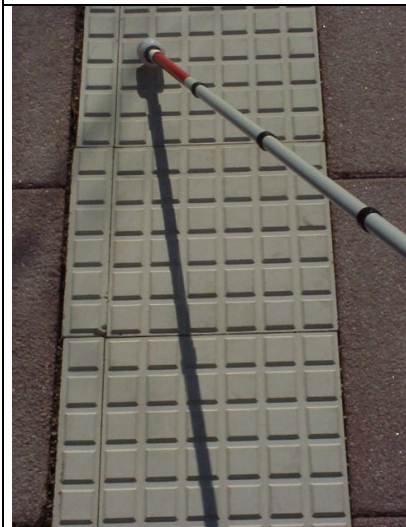
Abb. 13 i: Waffelstruktur (Leipzig) 13 mm (=Rillenbreite)/3mm Aufmerksamkeitsf.: 4,31
