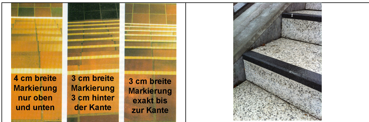
Abb. 4 a: Drei Beispiele für Markierungen bei den Treppentests ... Abb. 4 b: ... und als Ergebnis die optimal erkennbare und sichere Lösung
