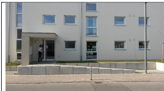
Abb. 16 Eine Rampe vor der Haustür deutet vorbildliche Barrierefreiheit an - wobei auch hier wichtige Normforderungen missachtet wurden (ca. 8.5 % Steigung statt max. 6 %; fehlender Handlauf).
