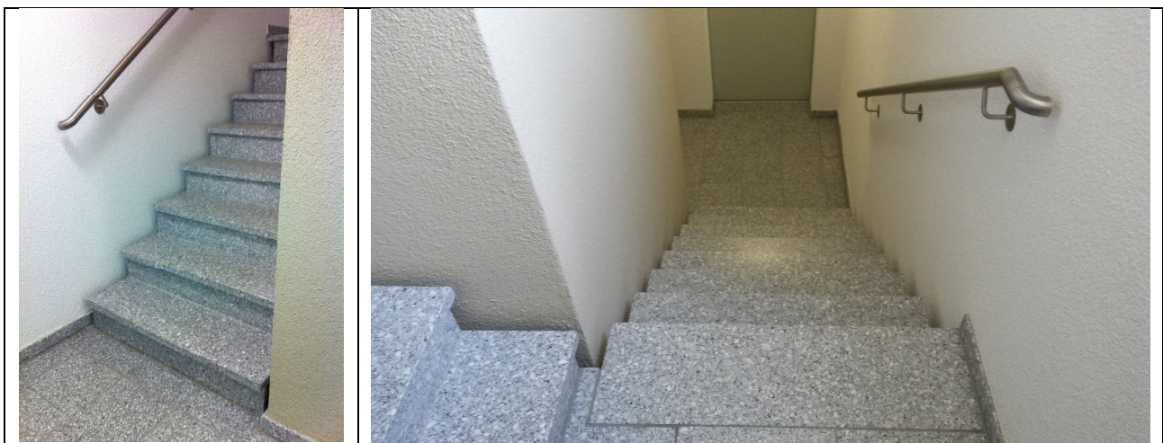
Abb. 17 Treppe in einem "barrierefreien" Wohnhaus-Neubau: gravierende Mängel!
