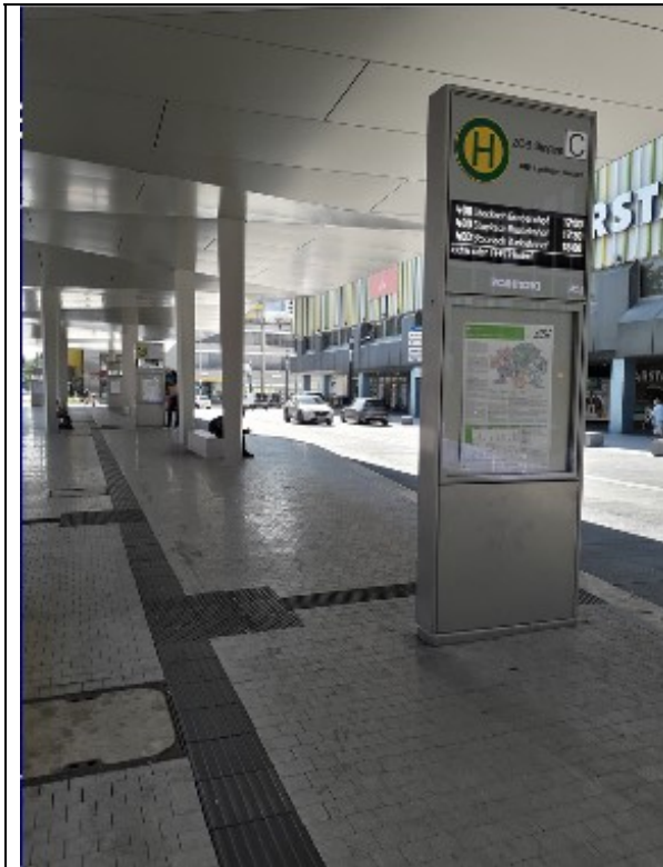
Abb. 4 Busbahnhof Singen, normgerechtes, geradliniges Leitsystem; Infostelen mit Sprachausgabe
