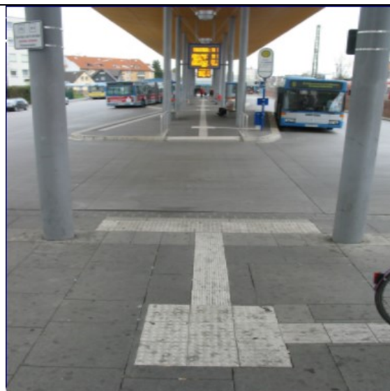
Abb. 1 Busbahnhof Rüsselsheim: Gut durchdachtes Leitsystem für blinde Menschen. Die Überquerung der Busspur ist aber von ihnen kaum leistbar.
