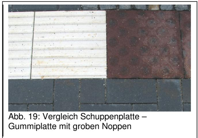
Abb. 19: Vergleich Schuppenplatte – Gummiplatte mit groben Noppen
