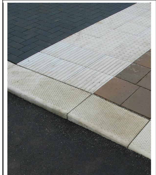
Abb. 32: Richtungsfeld bei Querungsrichtung rechtwinklig zur Bordsteinkante: **Zwingend notwendig?**
