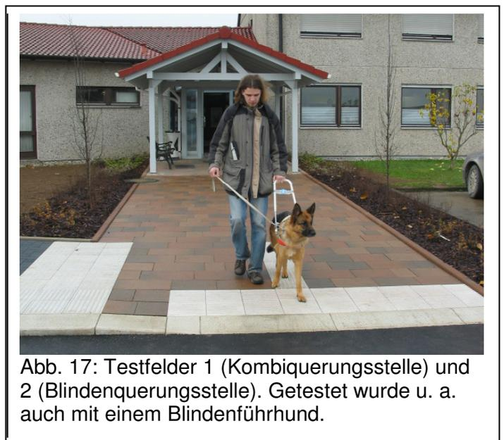
Abb. 17: Testfelder 1 (Kombiquerungsstelle) und 2 (Blindenquerungsstelle). Getestet wurde u. a. auch mit einem Blindenführhund.
