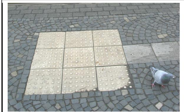
Abb. 11 – Bebelplatz Kassel: Obwohl qualitativvolle Noppenplatten verwendet wurden, sind sie weder mit dem Stock noch mit den Füßen sicher wahrzunehmen, da die Umgebung praktisch das gleiche „Tastbild“ ergibt.
