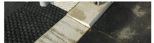
Abb. 25: Im Straßenraum würde vermutlich der senkrechte Versatz der Testsstrecke (zwischen Bordhöhe 6 cm und 0 cm) durch eine Verziehung ersetzt werden.
