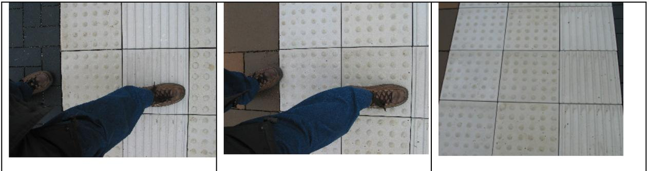
Abb. 34 – 36: Noppen sind mit den Füßen wahrnehmbar, Rippen dagegen nicht (außer bei sehr großem Rippenabstand) . Es ist daher relativ leicht möglich, dass ein Noppen-Rippen-Noppen-Streifen mit den Füßen nicht wahrgenommen wird, was bei einem Noppen-Noppen-Rippen-Streifen kaum möglich ist. Von der Mehrheit der Befragten wird aber auch diese Lösung nicht favorisiert: Gewünscht wird ein 90 cm breites Noppenfeld.
