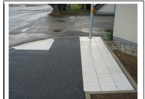
Abb. 23: Doppelquerungsstelle an einer Furt - Lösung A (Testfelder 7/8)
