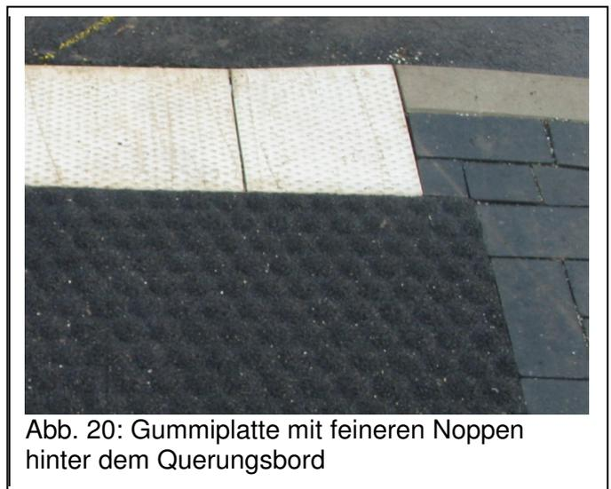
Abb. 20: Gummiplatte mit feineren Noppen hinter dem Querungsbord
