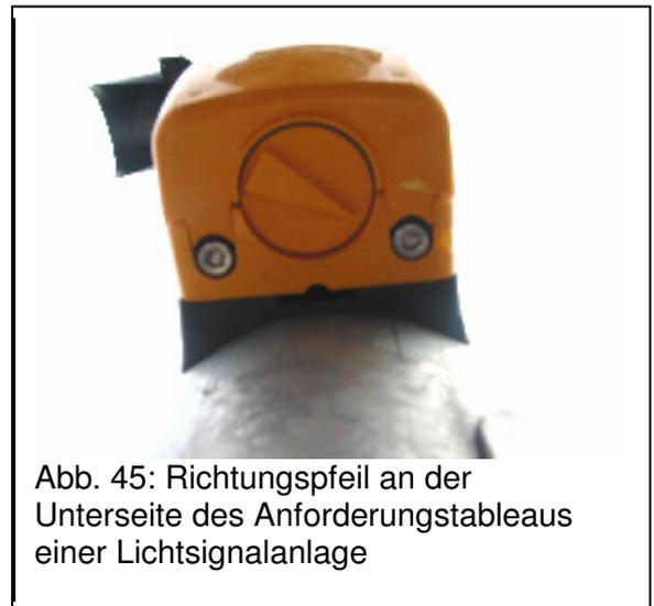
Abb. 45: Richtungspfeil an der Unterseite des Anforderungstableaus einer Lichtsignalanlage
