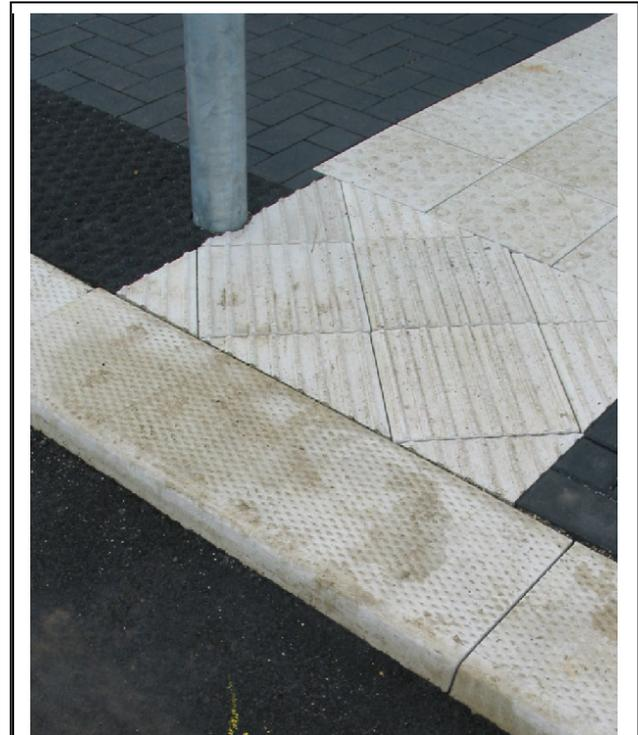
Abb. 31: Richtungsfeld bei Querungsrichtung schräg zur Bordsteinkante: **Zwingend notwendig!**
