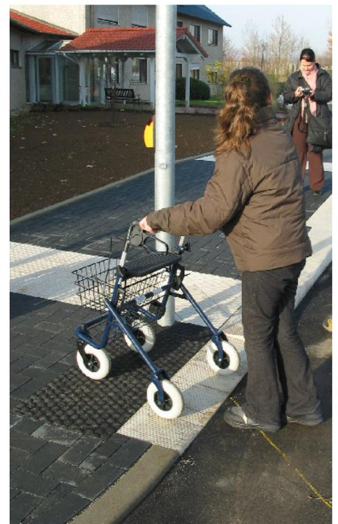
Abb. 27 - Lösung B: Kein Rangieren beim Abwärtsfahren ist notwendig, wenn sich die Anforderungstaste direkt neben der Rampe befindet.
