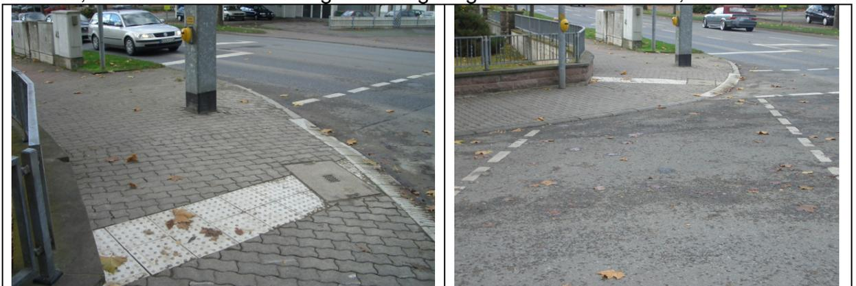
Abb. 9+10: Extrem fehlerhafte Gestaltung einer angeblich „gesicherten Nullabsenkung“ (mit Kasseler Rollbord; Hofgeismar 2004): Der blinde Nutzer wird weit an der Bedarfsampel vorbei geführt, so dass das Anforderungstableau für ihn kaum auffindbar ist. – Der Schachtdeckel irritiert. – Der Aufmerksamkeitsstreifen lenkt den blinden Nutzer direkt in die gefährliche Kreuzungsmitte. (Fotos: Willumeit)
