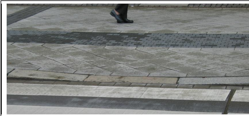
Abb. 12 – Bebelplatz Kassel: Diese Nullabsenkung wurde von den blinden Testpersonen und den Mobilitätslehrern als außerordentlich gefährlich eingestuft, zumal sich in der warmen Jahreszeit hier ein Straßencafé auf dem Gehweg ausbreitet, das den Fußgängerstrom zur Bordsteinkante hin abdrängt..
