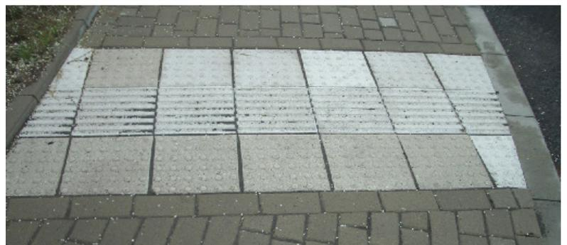
Abb. 33: Genoppeter Aufmerksamkeitsstreifen mit integriertem Richtungsfeld: Liefert die Test-Idee von Lischeid die optimale Lösung? (Aufnahme: Willumeit)
