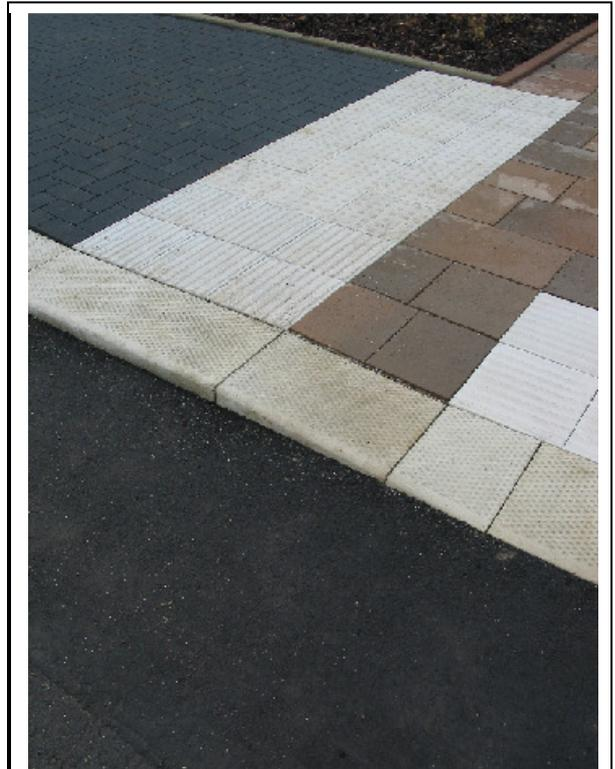
Abb. 18: Das Prinzip der Doppelquerungsstelle: rechts Nullabsenkung, links 5 cm hohe Kante
