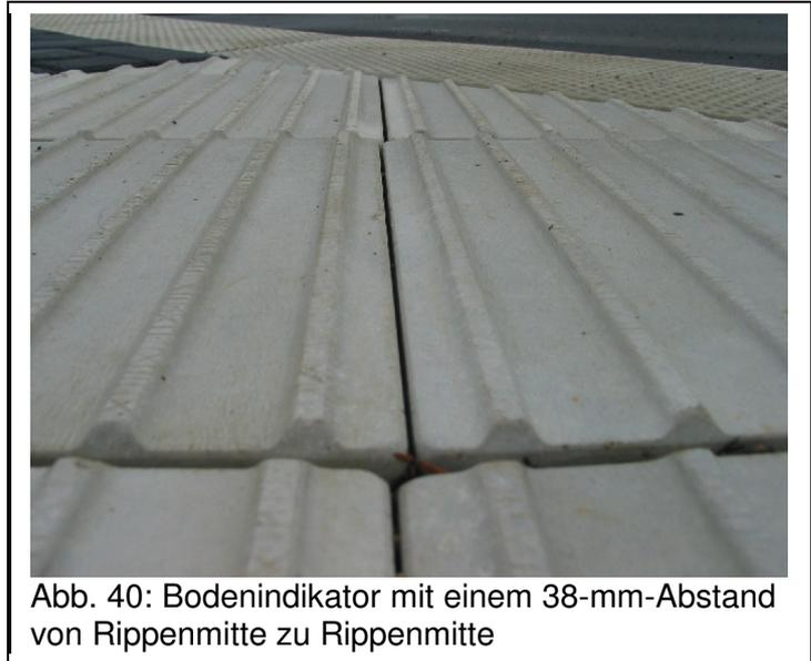
Abb. 40: Bodenindikator mit einem 38-mm-Abstand von Rippenmitte zu Rippenmitte
