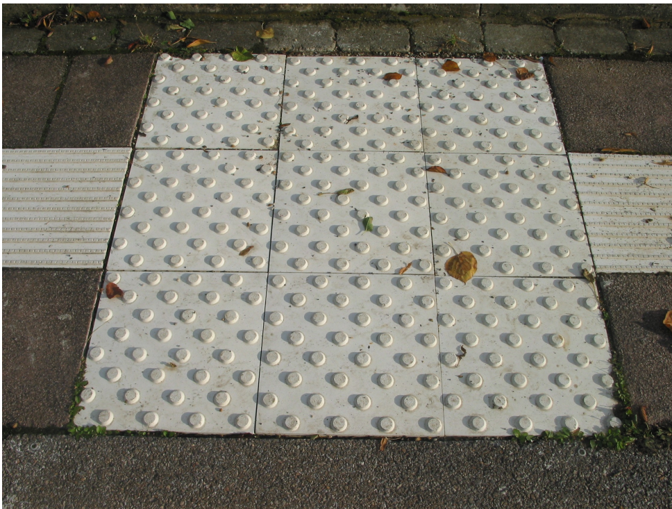
Abb. 12: Diagonal angeordnete Noppen haben den Vorteil, dass der Blindenstock nicht ungebremst zwischen den Reihen durchgleiten kann. Diese Anordnung wird daher favorisiert.
