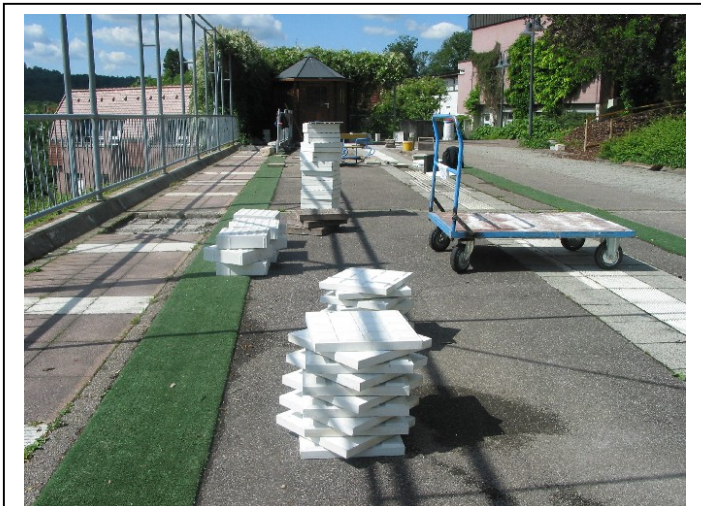
Abb. 1: Einer der zahlreichen Umbauten und Erweiterungen der Teststrecke. Erkennbar sind rechts die Testfelder der Leit-, links die der Aufmerksamkeitsstrukturen.
