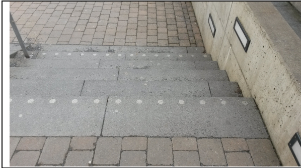
Abb. 8 a: Wer auf einer Treppe ins Straucheln kommt, muss in Bruchteilen von Sekunden erkennen können, wo genau er seinen Fuß sicher absetzen kann. Bei einer mit Punkten markierten Treppenstufe ist dies enorm erschwert bis unmöglich, da die Kante kaum erkennbar ist.
