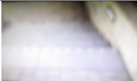
Abb. 8 b: Simulation eines schlechten Sehvermögens. Der Kontrast zwischen Wand und Treppe ist noch erkennbar; Treppenstufen und Markierungen sind jedoch nicht mehr zu unterscheiden. Wenn Treppen auf diese Weise gestaltet sind, werden Gefahren einprogrammiert - nicht nur für sehbehinderte Menschen.
