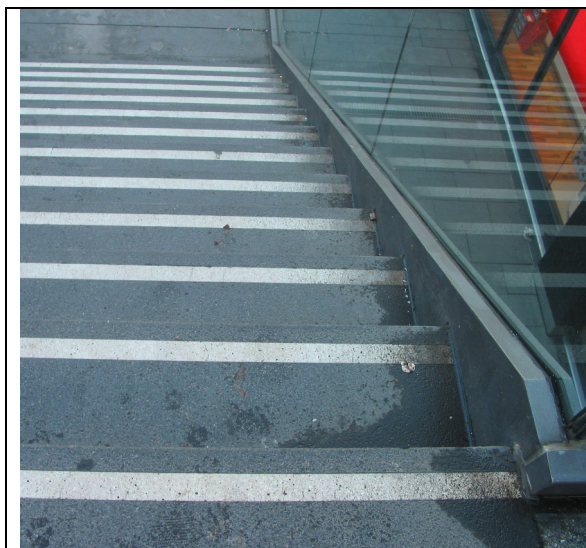
Abb. 9: Blickt man in Richtung Treppengänge, ist die Treppenstruktur gut erkennbar. Im Mittelbereich der Treppe (siehe linker Bildrand!) dominiert jedoch der Markierungsstreifen. Folge: Die eigentlich wichtigen Stufenkanten können leicht übersehen werden: Die zurückgesetzte Markierung provoziert „Stolperzentimeter“.
