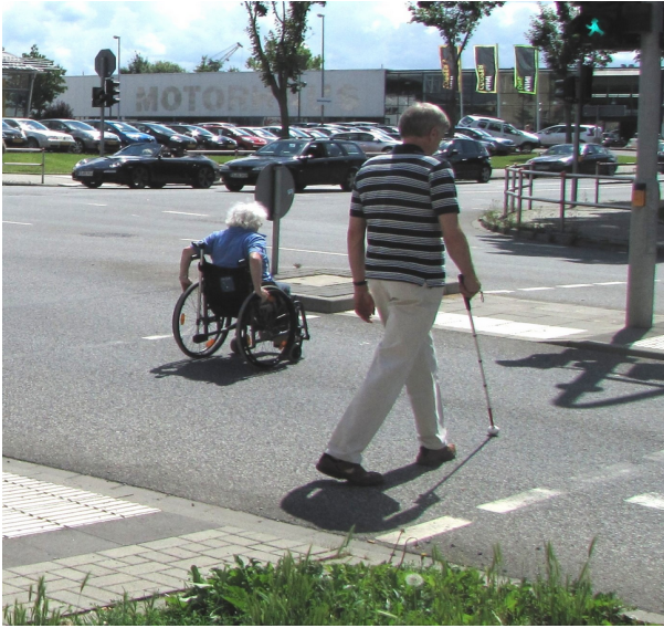
Bild 3: Der Grundgedanke ist nahe liegend: Rollstuhl- und Rollatornutzende erhalten eine kantenlose Überfahrt, blinde und sehbehinderte Menschen dagegen eine ausreichend hohe, gut mit dem Blindenstock ertastbare und gut sichtbare Kante.
