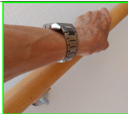
Abb. 3 Handlauf, Ø 4 cm, der auch verunsicherten Menschen sicheren Halt bietet
