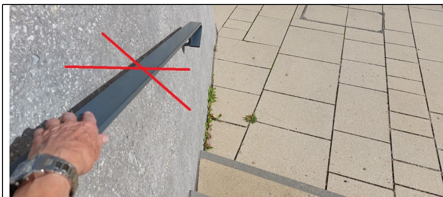
Abb. 5 Gleichartiger Handlauf, ca. 2022 an einer viel begangenen Treppe im öffentlichen Freiraum eingebaut.
