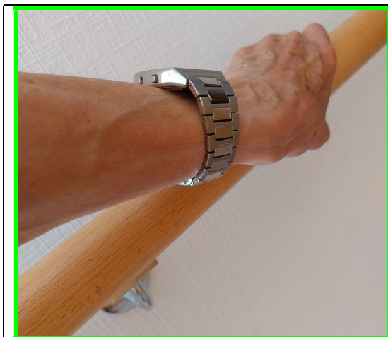
Abb. 7 Eine Hand greift auf einen Handlauf mit einem Durchmesser von 4 cm, der auch verunsicherten Menschen sicheren Halt bietet
