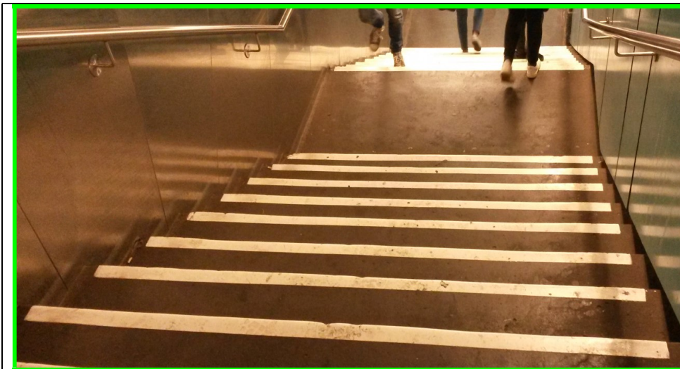
Abb. 17 a) Zugangstreppe zu einer Berliner S-Bahn-Station mit optimalen Stufenkanten- Markierungen
